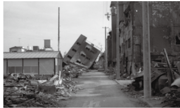
耐震改修促進法における特定建築物
